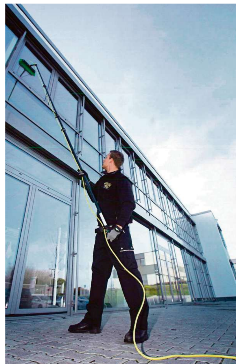
Die Osmose-Reinigung ermöglicht es, Flächen ohne chemische Reinigungsmittel zu behandeln. Selbst in großen Höhen kann dabei vom Erdschoß aus gearbeitet werden.
